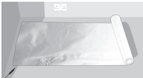
Fig. 5. Installation du tapis chauffant
