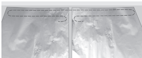
Рис. 6. Разматывание мата, резка фольги и разворот
