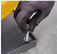
Insérez les goujons dans les pré-perçages au pied du poteau. Vous devez sentir qu'ils traversent la semelle pour aller se loger dans le forage sous le socle. Positionnez ainsi les 4 goujons.
