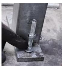
Insérez les goujons dans les pré-perçages aux pieds des boucliers. Vous devez sentir qu'ils traversent la semelle pour aller se loger dans le forage sous le socle. Positionnez ainsi les 4 goujons.
