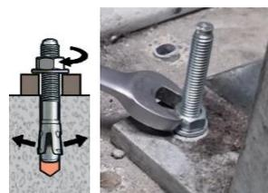
Munissez-vous d'une clé de serrage **17 mm** et serrez au maximum les écrous sur les 4 goujons.
