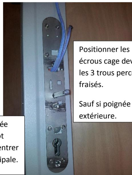
4- Placer la tige carrée « D » dans le fouillot serrure pour bien centrer la sous plaque principale.
