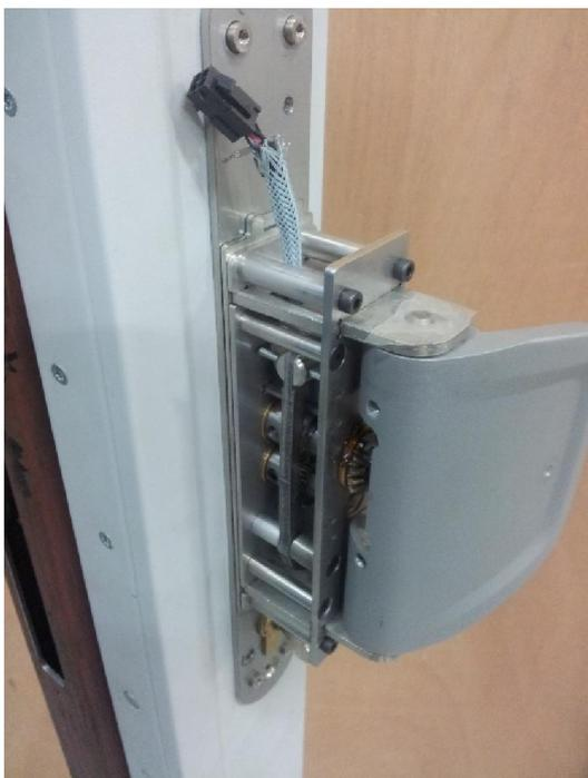
13- Replacer le module « C » avec sa tige carrée « D ».
