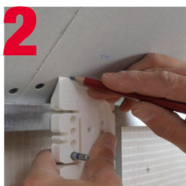
2 Biseau pour tracer/mesure plaque sous rampants.
