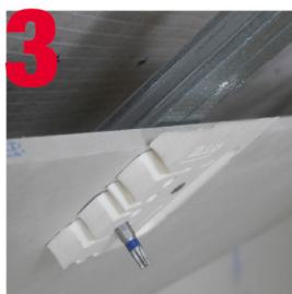
3 Maintien de la plaque en pose rampant
