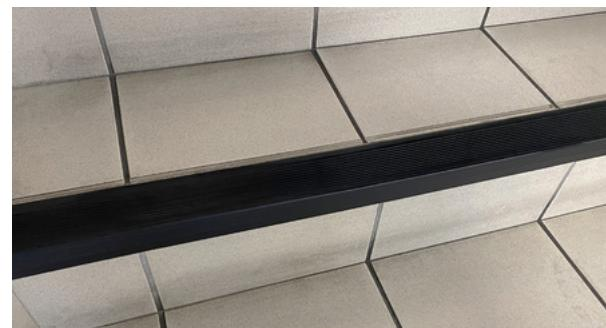
**DIMENSIONS****Dimensions (L\*I\*H en mm) : 3 m x 75 mm x 45 mm****Épaisseur (mm) : 2.8****Hauteur (mm) : 45****Largeur (mm) : 75****Largeur antiderapant (mm) : 50****Longueur (mm) : 3000****NORMES APPLICABLES****Nez de marche**
