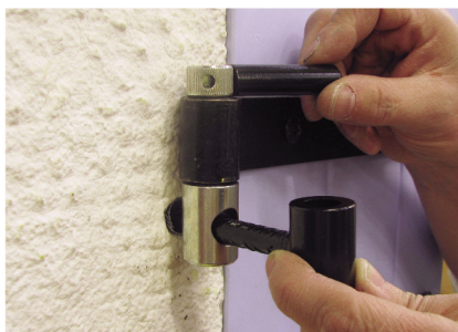
Le bloquer à l'aide de la clavette et de la queue du gond.
