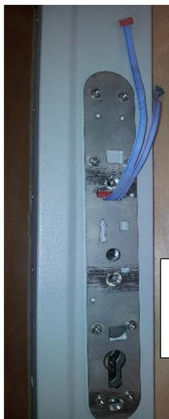
3- Positionner les écrous cage devant les 3 trous percés fraisés.
