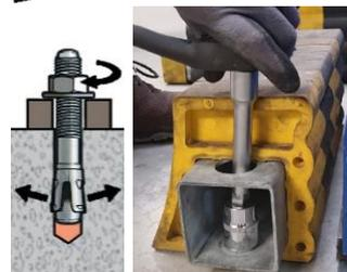
Munissez-vous d'une clé de serrage **24 mm** et serrez au maximum les écrous sur les goujons.
